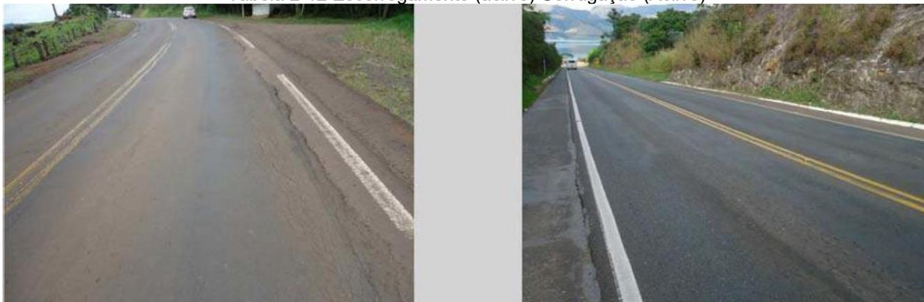
No cálculo da área de ocorrência das trincas isoladas (longitudinal e transversal) foi adotado o critério estabelecido pela Norma PRO-007 (DNIT, 2003). A localização de cada tipo de defeito cadastrado foi obtida com o auxílio de odômetro veicular DMI e dispositivo GPS, os quais registram a posição (km início e final) e georreferenciamento, respectivamente.
