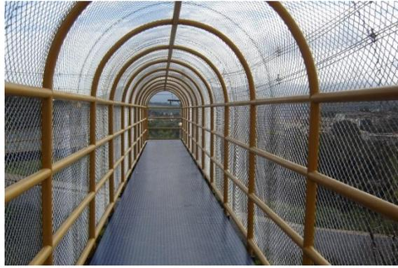
Figura 6-9 Sugestão de proteção para pedestres e ciclistas na travessia sobre a ponte
