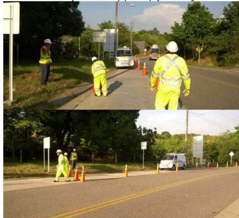
Sinalização de Vias da Equipe de Inspeção de Tráfego
